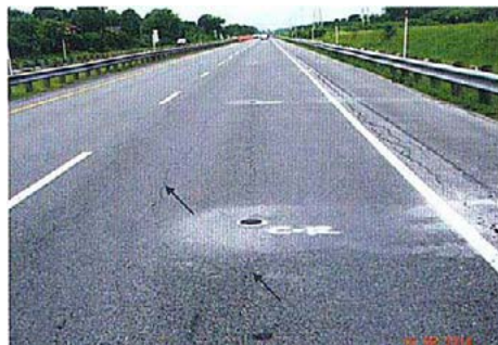
c) Serimden 6 yıl sonra aynı yolda yüzeydeki çatlakların durumu ve karot örneğinin alındığı yer
