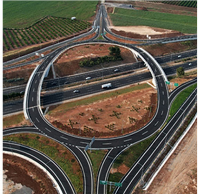
TAG Otoyolu Baklalı Kavşağı ve Üstü yapı Onarım İş
