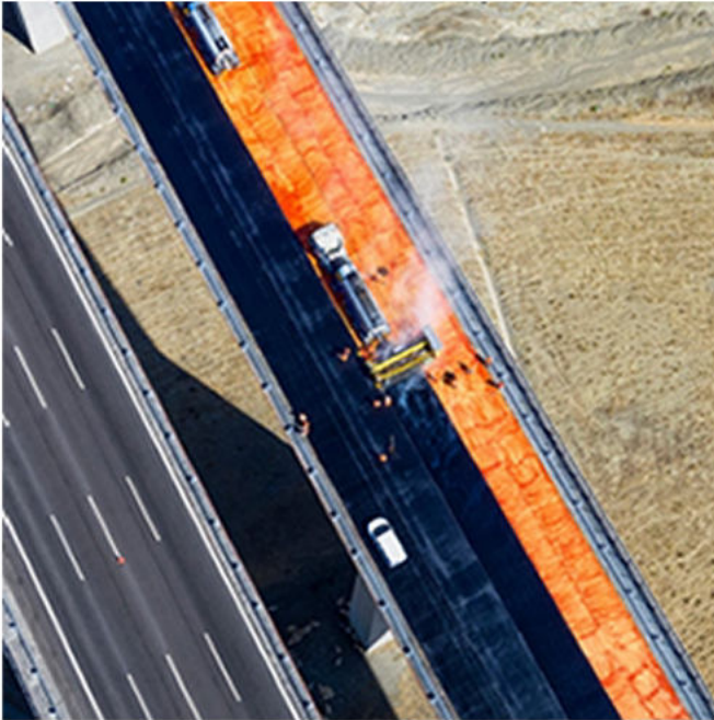
Ankara Çevre Yolu Karataş Viyadüğü Guss Asfalt
