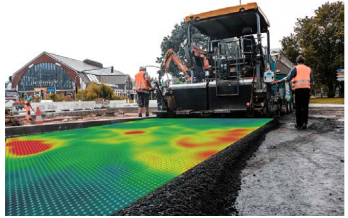
Akıllı finişer ile sıcaklık kontrolünün temsili örneği
