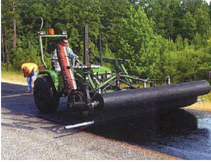
Kaplama Hasırı Döşenirken
